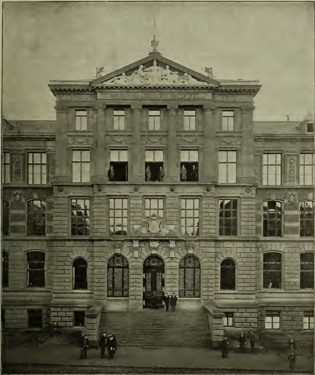
Abbildg. 4 Mittelbau des Hauptgebäudes.
